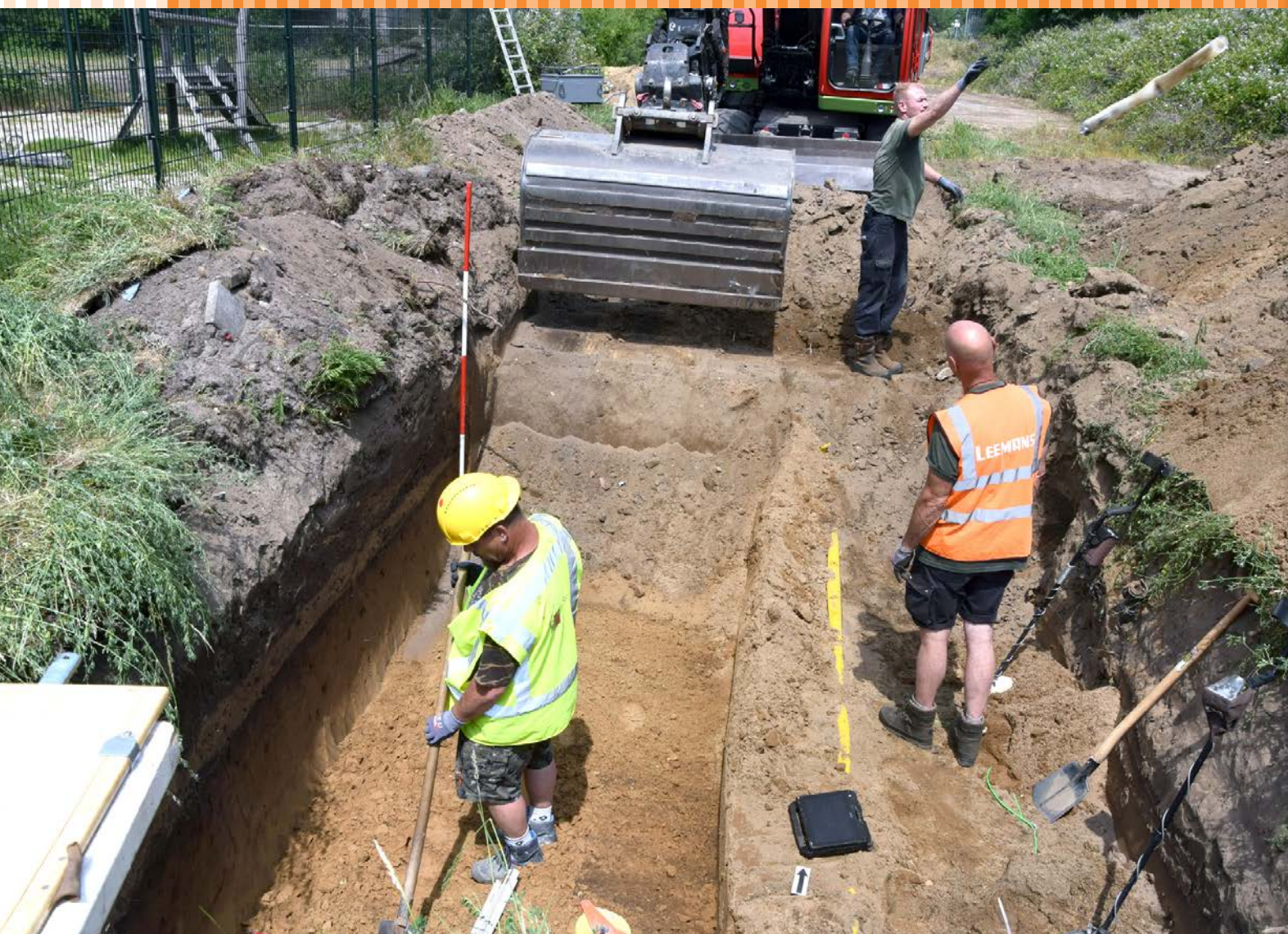
Gecombineerde uitvoering van 000 en archeologie bij proefsleuvenonderzoek in Westerkwartier in Nijmegen (Foto: Gemeente Nijmegen).
